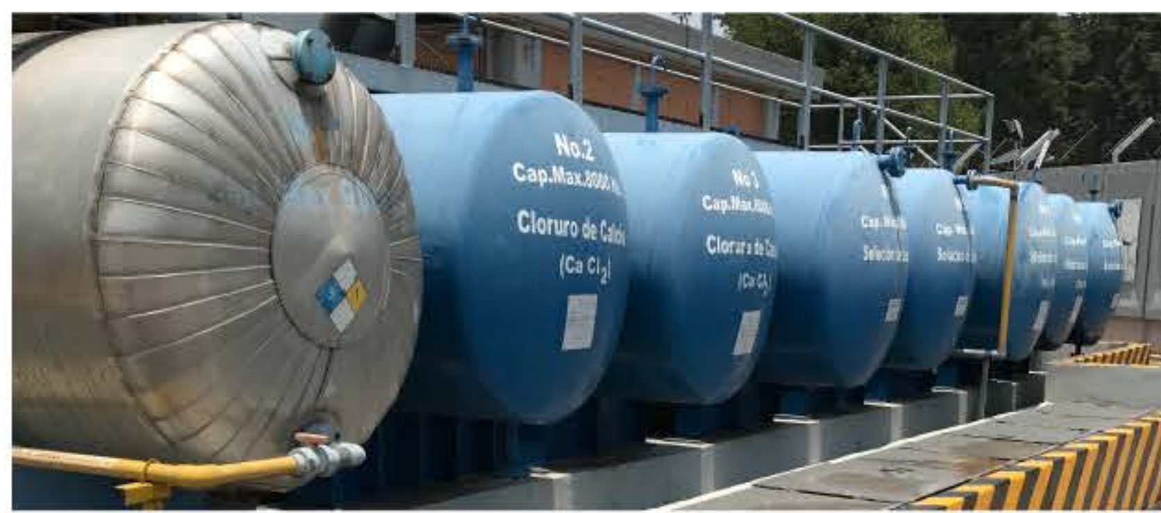
Imagen 3. Tanques atmosféricos que contienen residuos peligrosos y sustancias químicas peligrosas para la impresión de billetes del proceso calcográfico.
